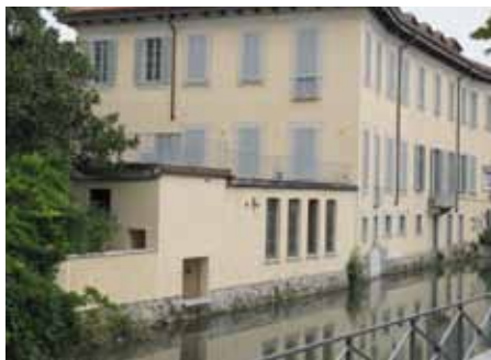
Esterno della Villa Pallavicini
